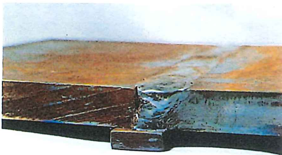
端部処理の不良によるもの
