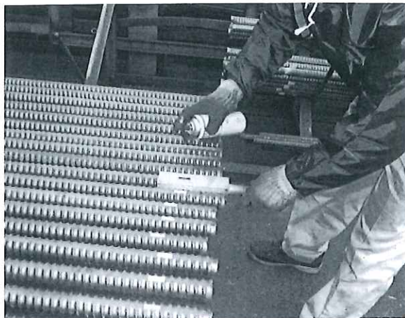
写真 6.2 挿入マークの作業状況 (加工工場又は現場でマーキングする)
