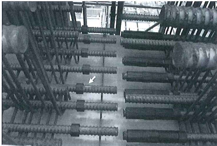
写真 6.4 挿入マークの確認（鉄筋組立て後、継手作業前に挿入マークが施されていることを確認する。-ねじ節鉄筋継手の例）
